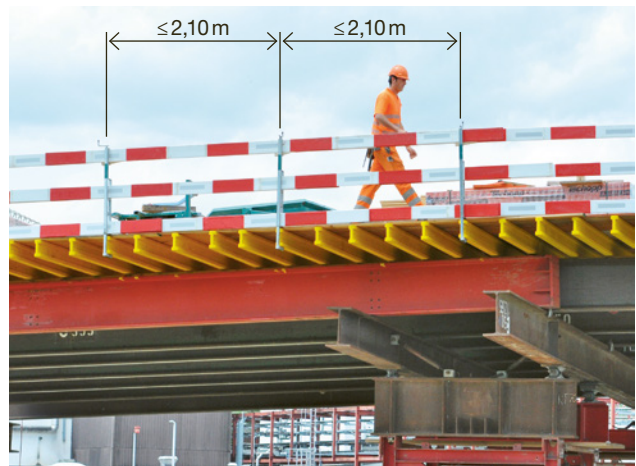
1 Seitenschutz mit rot-weissen Absperrlatten: maximaler Pfostenabstand 2,10 m
