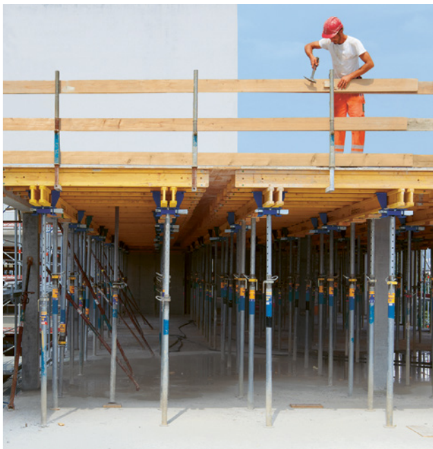
3 Seitenschutz mit Schutzgelenkerzwingen
